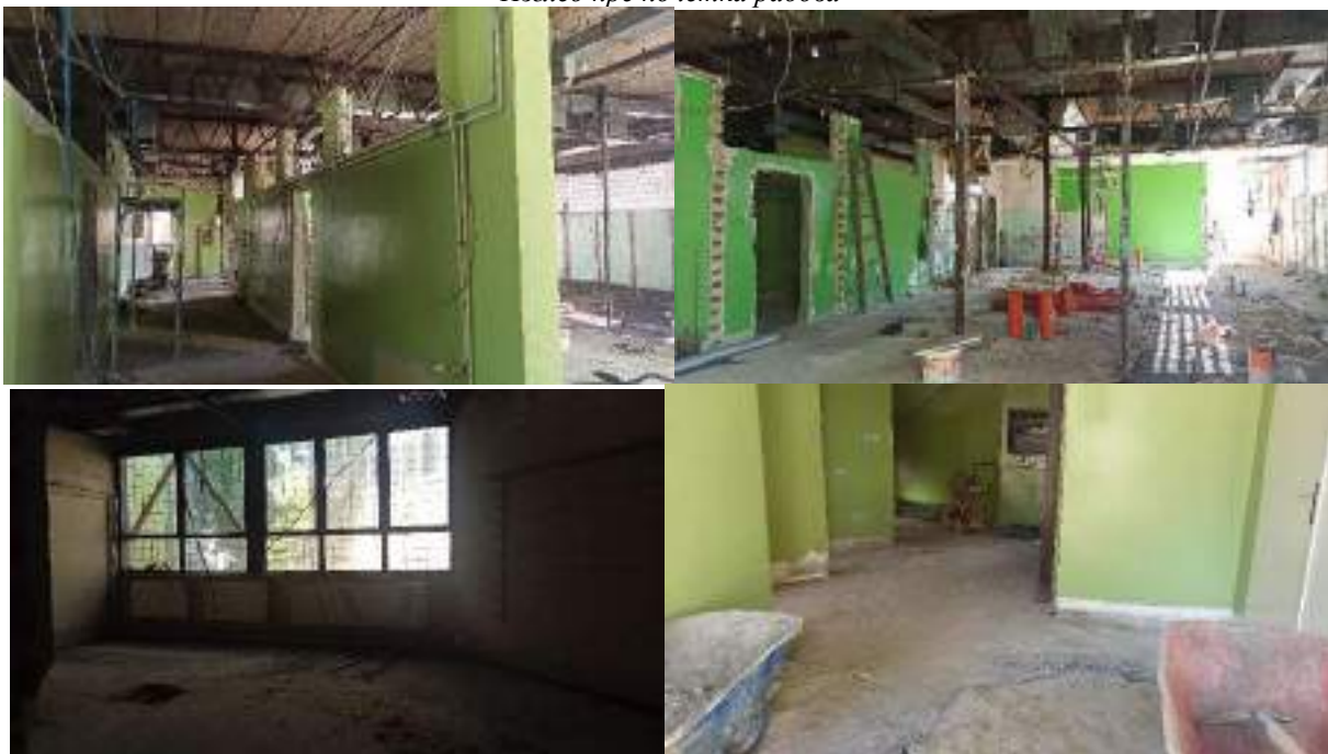
Изглед током радова
