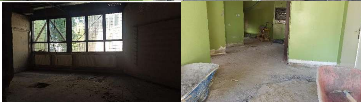
Изглед током радова
