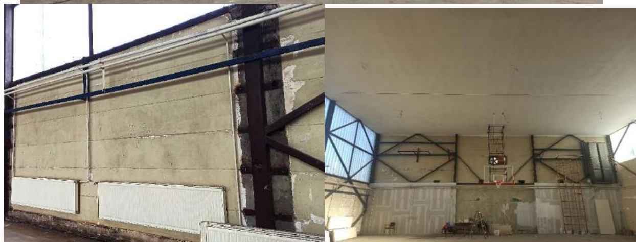
Изглед фискултурне сале пре реконструкције
