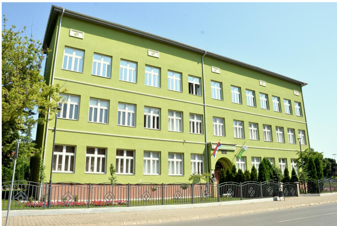
Стара, задужбинска школска зграда у потпуном новом сјају, по завршеној реконструкцији
