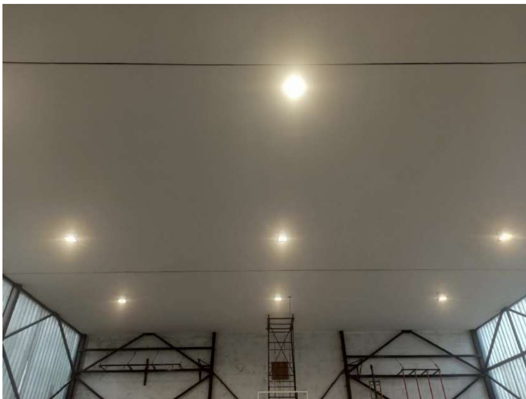
Урађена је енергетски ефикасна реконструкција плафона, са новим осветљењем
