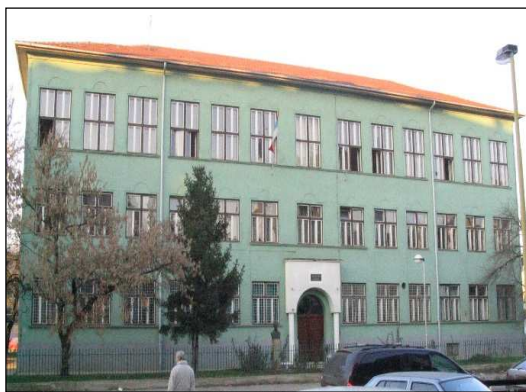
Стара, задужбинска зграда, пре надоградње
