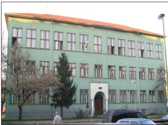
Стара, задужбинска зграда, пре надоградње
