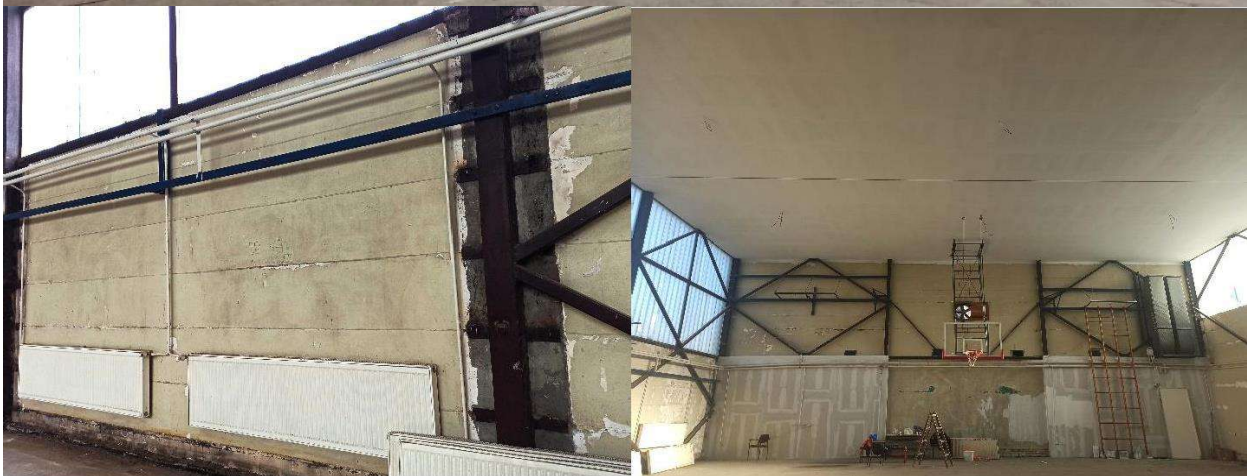
Изглед фискултурне сале пре реконструкције
