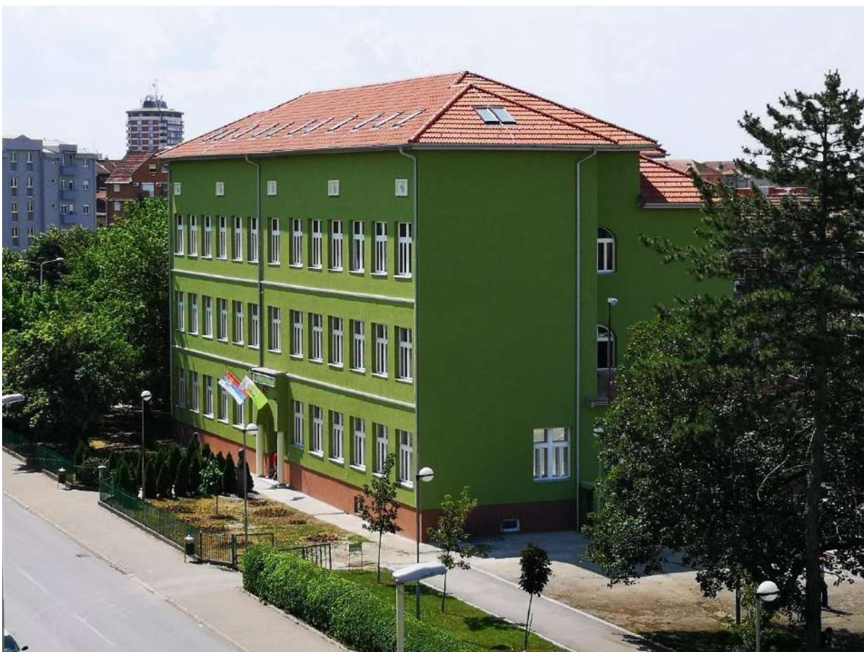
Стара, задужбинска школска зграда у потпуном новом сјају, по завршеној реконструкцији
