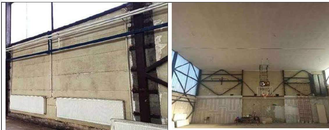
Изглед фискултурне сале пре реконструкције
